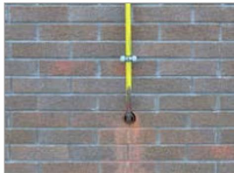
In caso di brevi **attraversamenti** di locali porre le **tubazioni** in **guaina** di **classe A1** di reazione al fuoco, aerata alle due estremità verso l'esterno e di  $\Phi \geq 20$  mm rispetto alla tubazione interna.
